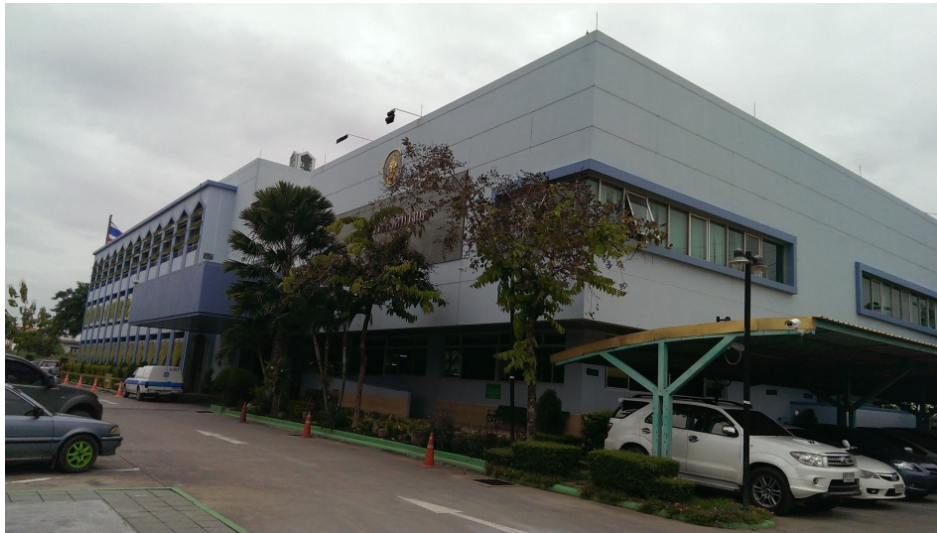
ภาพที่ 4.2 โครงสร้างด้านนอกอาคารสำนักงานเขตบางแคอาคารที่ 1 จำนวน 3 ชั้น
