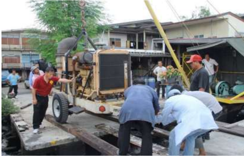
ภาพที่ 4.8 เทศบาลนครสมุทรสาคร ติดตั้งเครื่องสูบน้ำ เพื่อรับมือกับเหตุการณ์น้ำทะเลหนุน แหล่งที่มา: สำนักเทศบาลนครสมุทรสาคร, ม.ป.ป.
