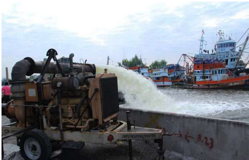
ภาพที่ 4.6 เครื่องสูบน้ำที่ติดตั้งและเดินเครื่องบริเวณฝั่งท่าลอม แหล่งที่มา: สำนักเทศบาลนครสมุทรสาคร, ม.ป.ป.
