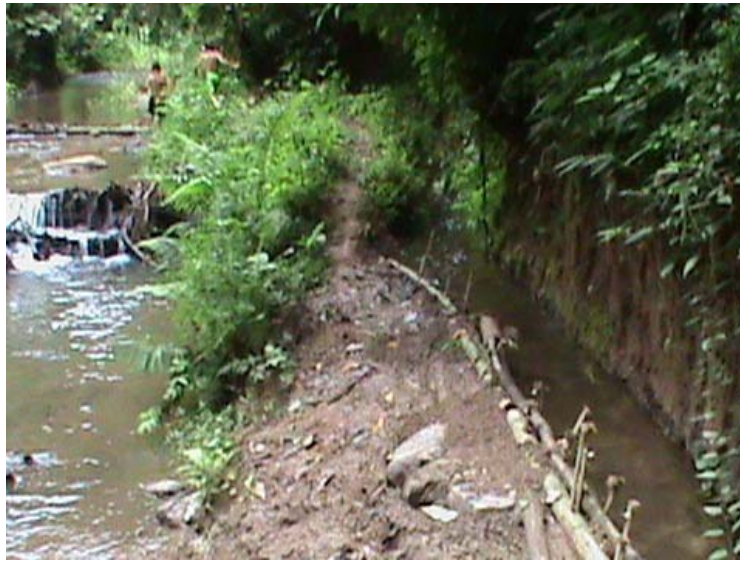
ภาพที่ 4.25 การทำเหมืองฝายเพื่อผันน้ำเข้านาขั้นบันได
