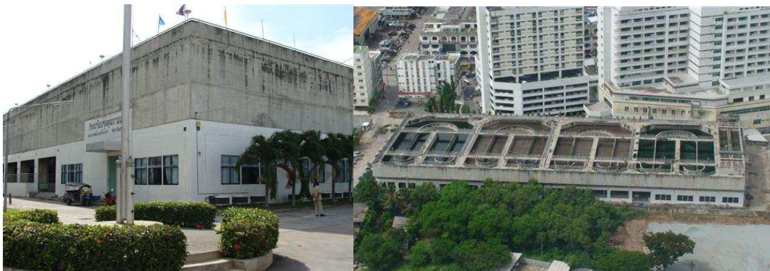
ภาพที่ 4.4 โรงบำบัดน้ำเสียแบบคลองวนเวียนของเทศบาลเมืองศรีราชา
